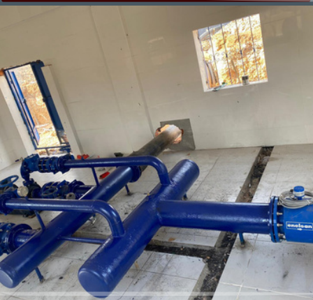
İÇME SUYU TEMİNİ İSALE YAPIM İŞİ UŞAK / KARAHALLI
