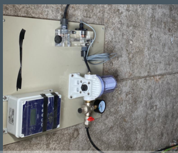
İÇME SUYU ŞEBEKE HATTI YENİLEMESİ BAYBURT / ARPALI
